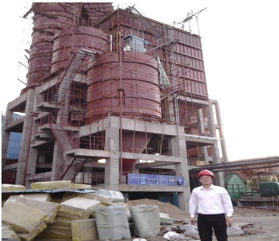
图 5-1 学校专业教师在硫化槽现场进行技术诊断
